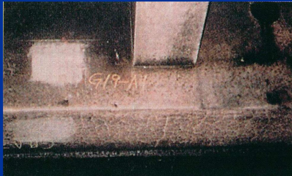
図2-5 火災を受けた構造物のひび割れ例
