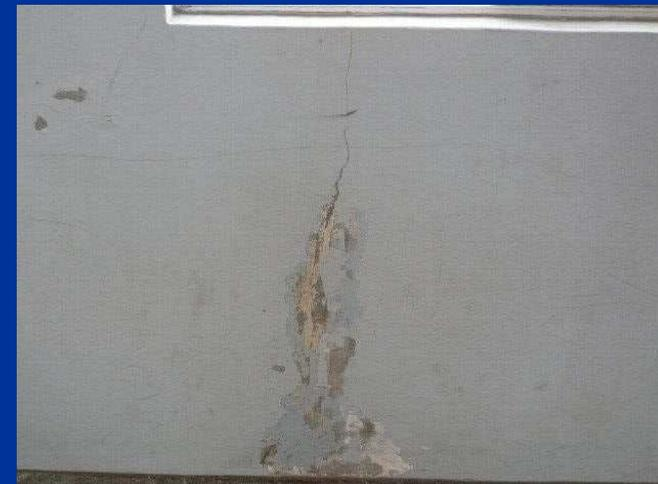
写真3-13 腰壁に生じたひび割れ
