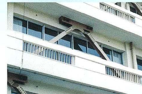
外付けS造ブレース補強例
