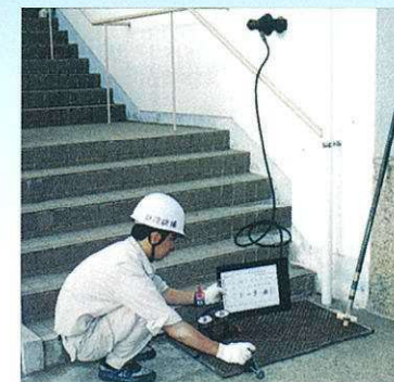
仕上げ材の接着強度試験
