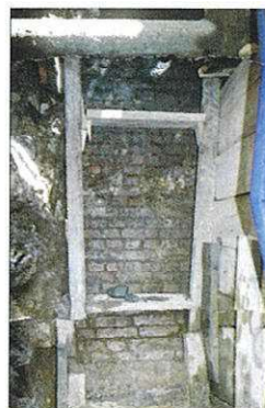
レンガ造建物の基礎確認調査
