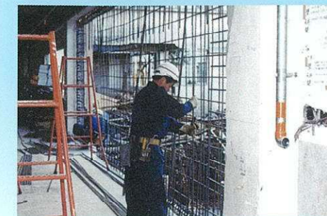
RC造壁増設施工状況
