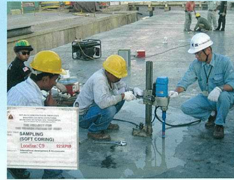
コンクリート強度判定調査
