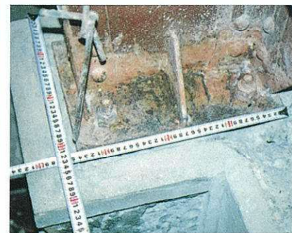
柱脚部の接合状況調査
