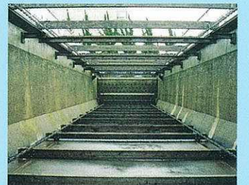
下水処理施設の劣化調査
