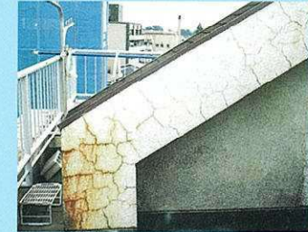
建物外壁面の劣化調査
