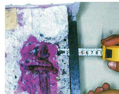
柱の析りによる中性化試験
