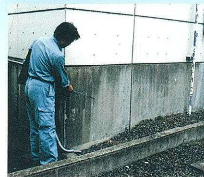
バリハンマーによる仕上げ材浮き上がり確認調査
