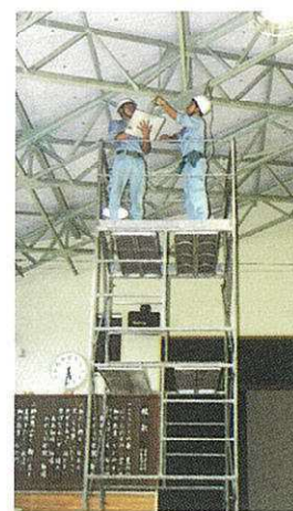
鉄骨部材の詳細調査ならびに、部材の変形量測定（ローリング足場使用）
