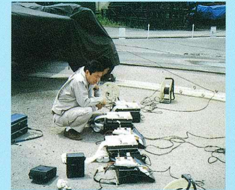
近隣工事に伴う振動測定
