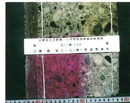
圧縮試験用コアの割裂による中性化試験
