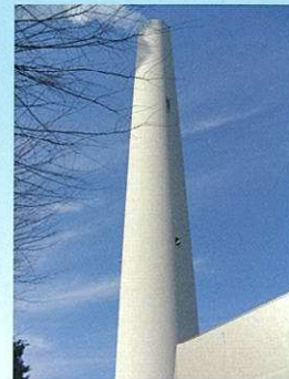
清掃工場煙突（H=100m級）耐震調査
