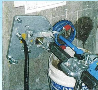
コンクリート小径コア採取
