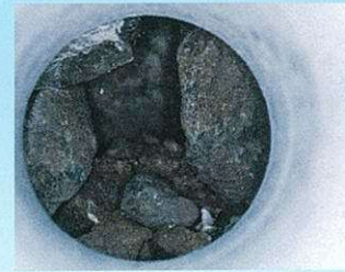
裏込め状況の確認調査
