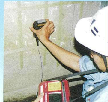
鉄筋探知器（プロフォメーター）による配筋調査
