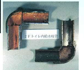
サンプリングによる配管の劣化調査
