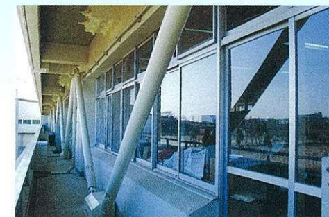
外付け制震ブレース補強例
