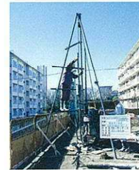
ボーリング調査
