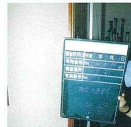
柱の傾斜測定
