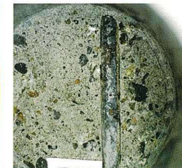
鉄筋かぶり厚さ・鉄筋腐食測定
