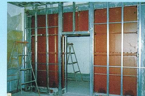
鋼板パネル補強施工状況
