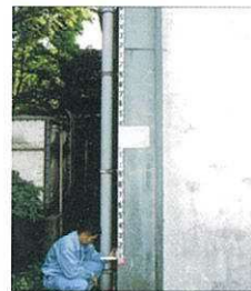
建物の傾斜測定
