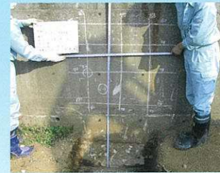
擁壁の傾斜測定
