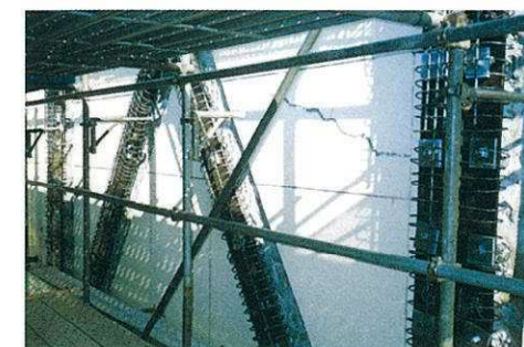
（補強施工状況）
