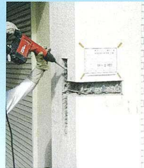
砕りによる配筋調査
