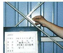
軸組ブレースの変形測定
