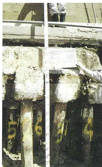
杭（松杭）基礎の確認調査
