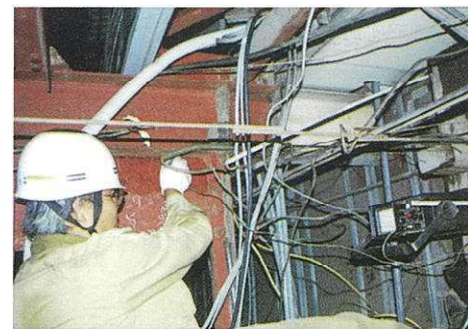
鉄骨接合部の超音波探傷検査
