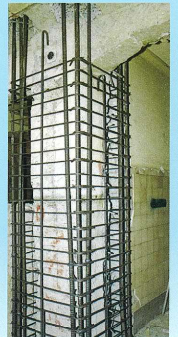
RC巻き補強施工状況
