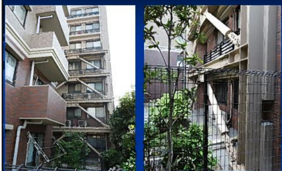
A棟(西側)＝耐震補強(鋼管ブレース工法)・・・1～4階部分
