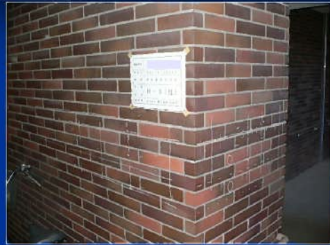
調査前の柱の現況
