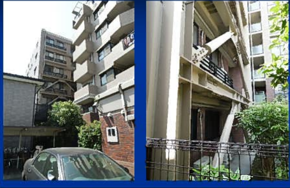
A棟(東側)＝耐震補強(鋼管ブレース工法)・・・1～4階部分
