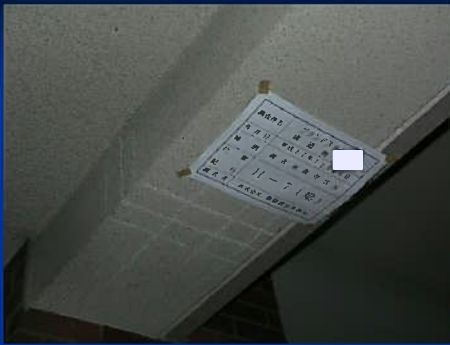
はつりによる梁の配筋調査
