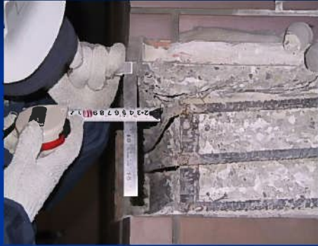
鉄筋かぶり厚さの測定
